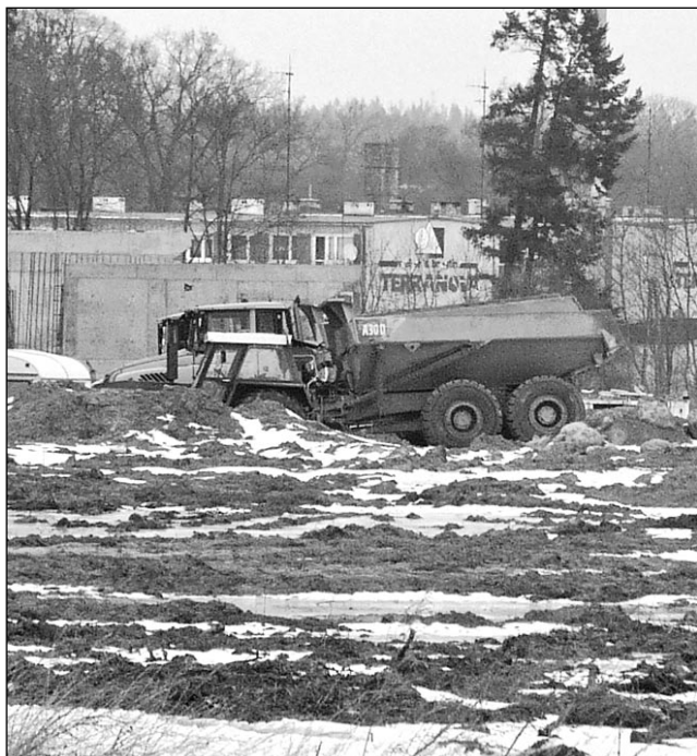
Prace przy budowie obwodnicy w Redzikowie
