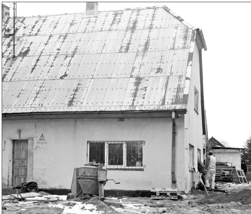
Trwa modernizacja świetlicy
