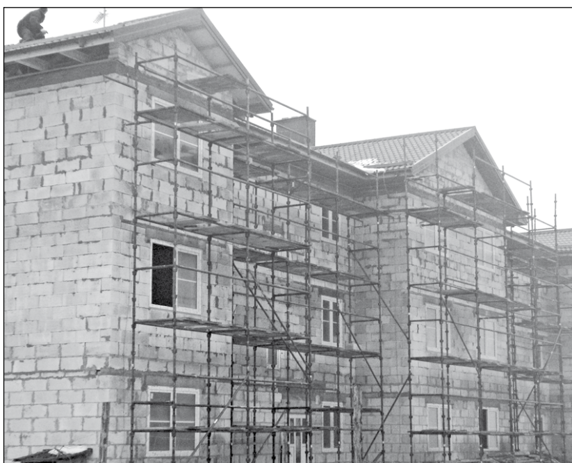
Trwa budowa bloku w Strzelinie.
