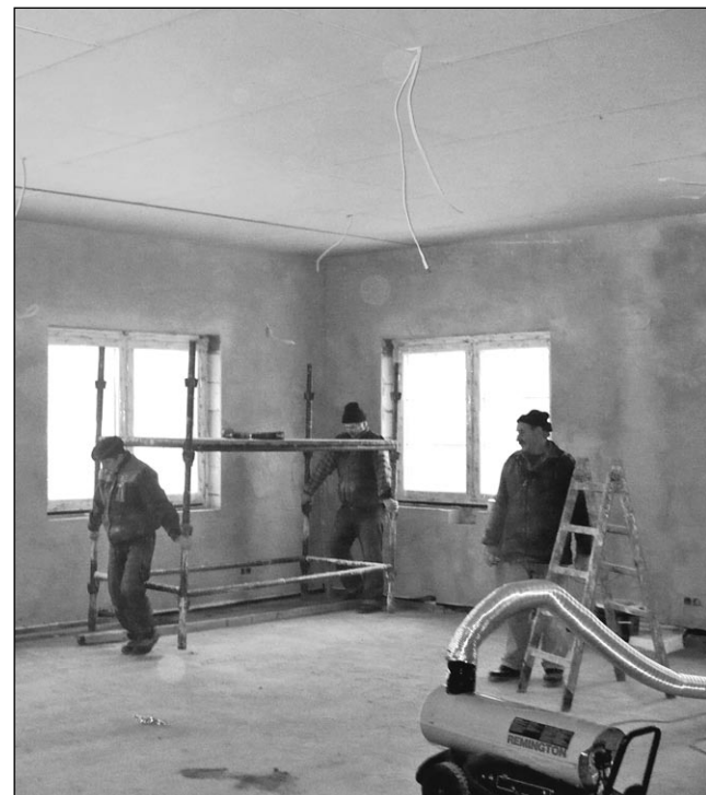
Trwają prace przy budowie świetlicy.
